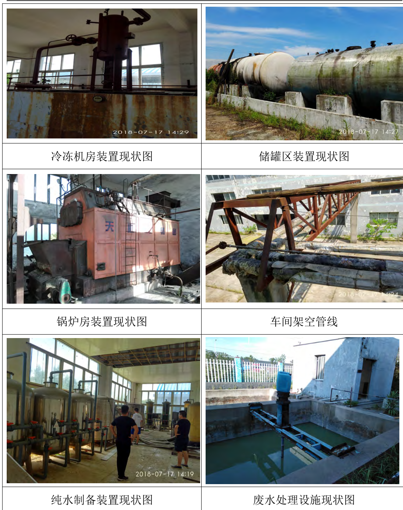
图 3-3. 信达化工有限公司陈场厂区现场踏勘图（续）
