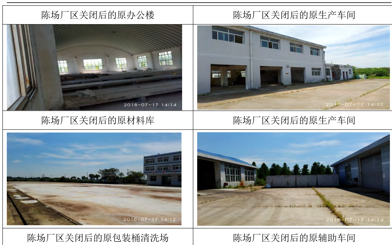
图 2-3 陈场厂区搬迁关闭后场地现状图
